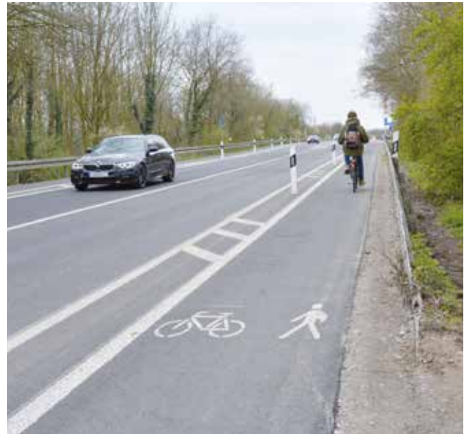
Der gesicherte Seitenbereich bewährt sich in der Praxis. Foto: Stadt Gladbeck
