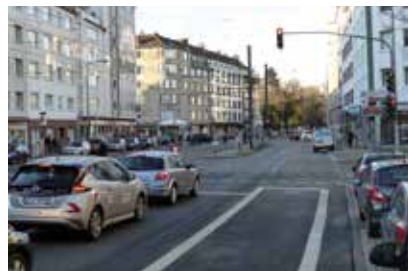
Geplanter Lückenschluss auf der Kölner Straße zwischen Gerresheimer Straße und Am Wehrhahn. Foto: Landeshauptstadt Düsseldorf/Amt für Verkehrsmanagement
