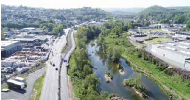
800 m neu gebauter Radweg in 4 m Breite. Foto: Stadt Arnsberg
