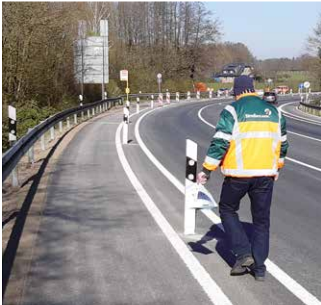
Ein Mitarbeiter von Straßen.NRW kontrolliert die Markierungsarbeiten. Foto: Stadt Gladbeck
