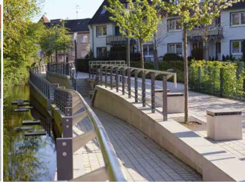
Rad fahren, flanieren und zwischendurch ans Wasser gehen: der neue Wiemannweg entlang der Berkel mit barrierefreiem Gehweg und dem Geh- und Radweg auf der zweiten Ebene. Foto: Stadt Coesfeld
