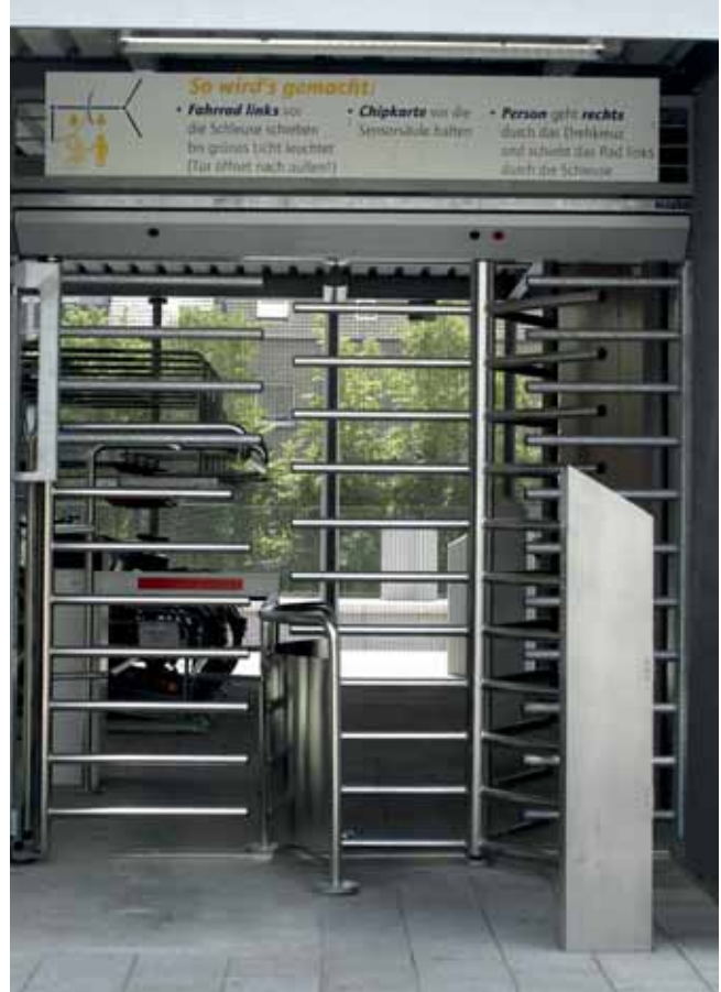
Automatische Zugangskontrollen bei Fahrradstationen folgen einem einheitlichen Standard und ermöglichen die Abstellung von Rädern 24 Stunden am Tag an 365 Tagen im Jahr.
