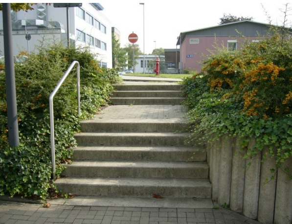
Neue Rampen (↔Barrieren)
